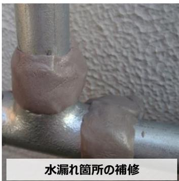
水漏れ箇所の補修
