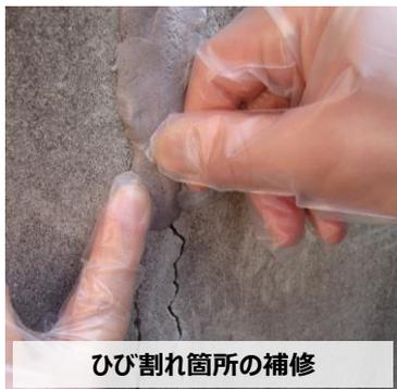
ひび割れ箇所の補修
