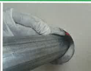
配管周辺もすき間なく充填してください
