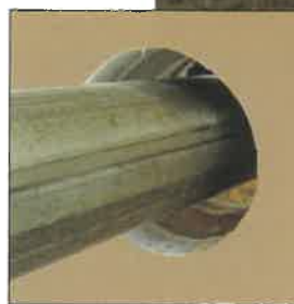
不燃性配管と開口部の すき間シール
