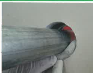
ボード内面から充填してください
